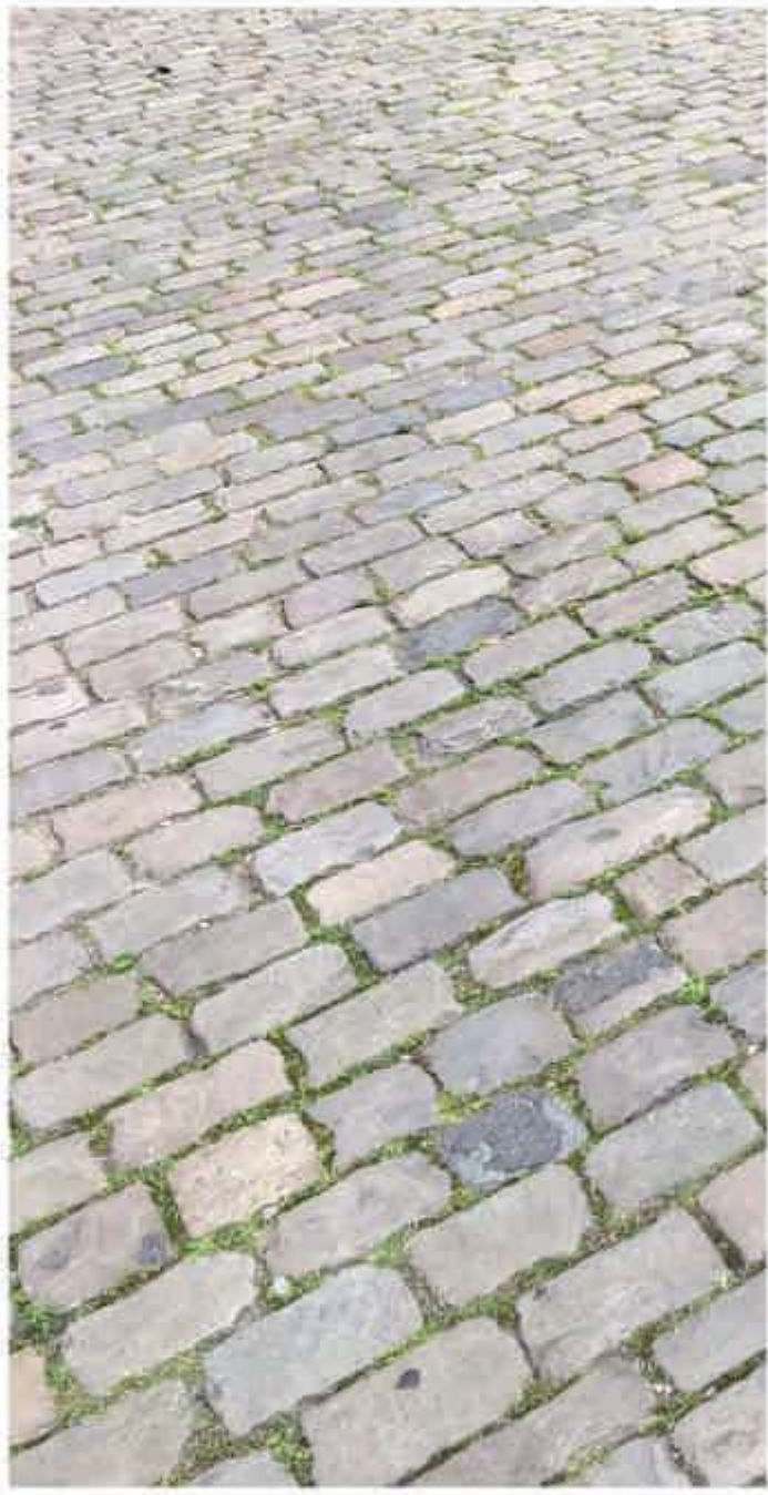
GRAUWACKE ALTPFLASTER AUS BESTAND GÜRZENICH WIEDEREINBAU MIT GESÄGTER OBERFLÄCHE
