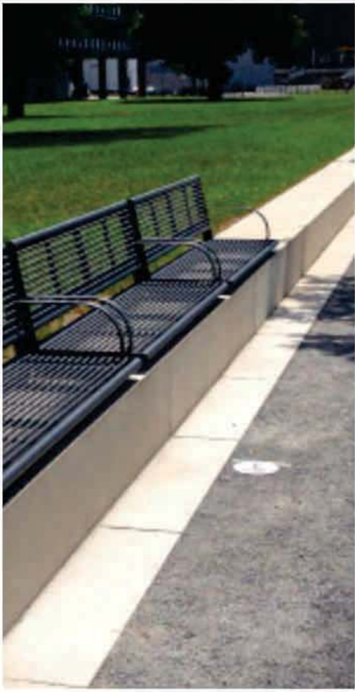
RANDEINFASSUNG AUS BETON MIT SITZAUFLAGE AUS METALL UND SCHARRSCHUTZ
